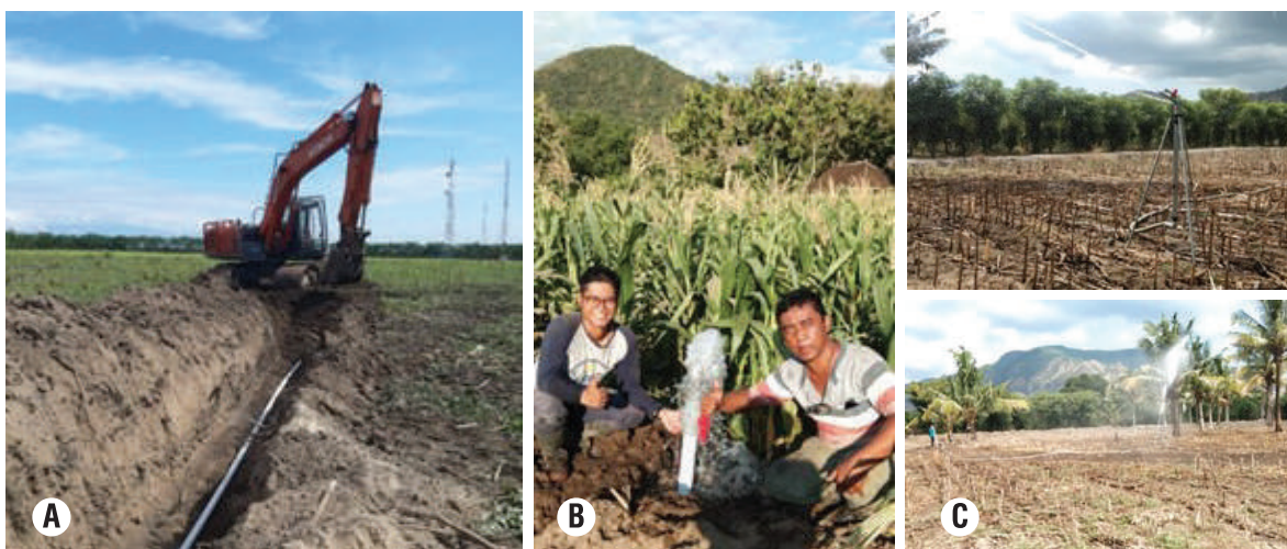
Tahapan kegiatan implementasi dilakukan dengan: (A) Penggalian saluran pipa irigasi menggunakan excavator (kiri atas), (B) Outlet irigasi untuk koneksi selang big gun sprinkler , (C) Sistem penyiraman jagung pada lahan menggunakan big gun sprinkler .
